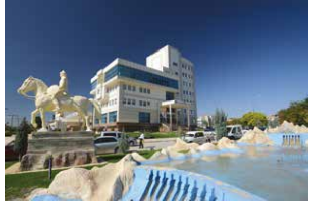
Görsel 5.2: Elâzığ Belediye Binası
